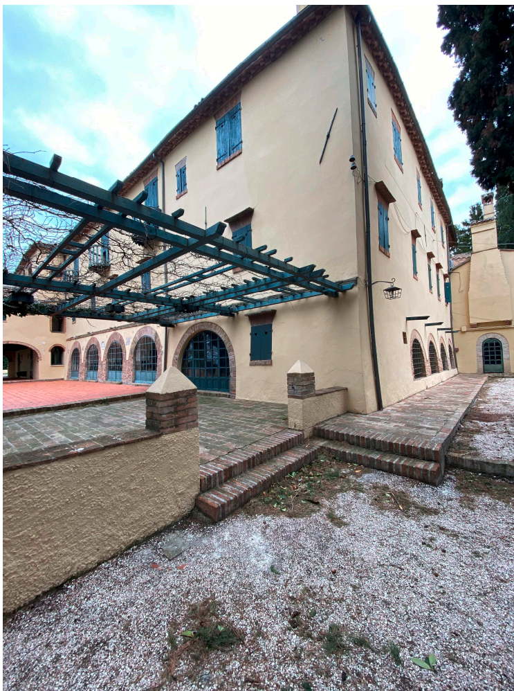
Punto di presa fotografia lato sud-ovest
