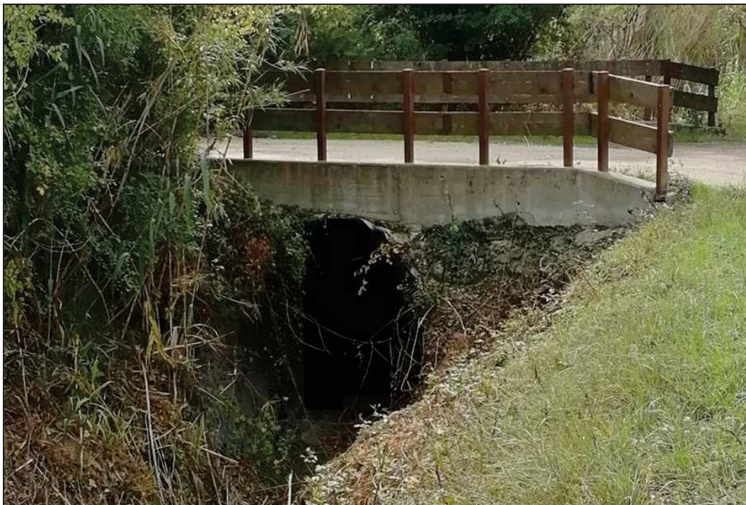
Figura 3-6 Dettaglio dell'attraversamento costituito da una condotta in metallo corrugato di grande diametro.
