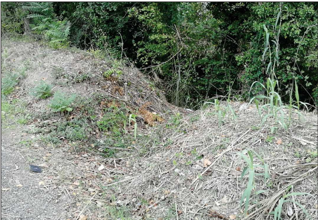
Figura 3-10 Taglio nell'arginello per permettere il deflusso delle acque superficiali in alveo.
