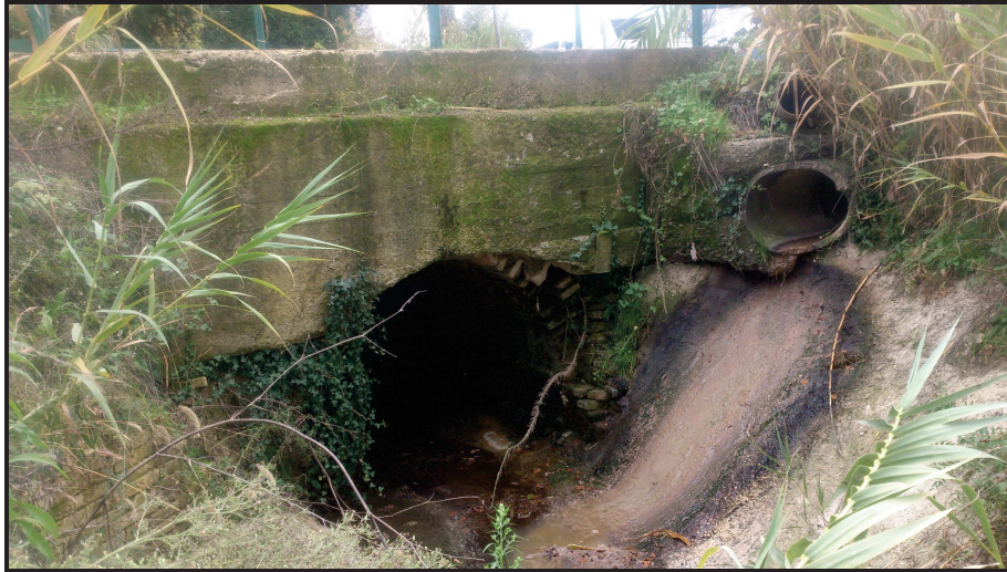
Figura 3-4 Ponte lungo via Cerreto lato di valle.
