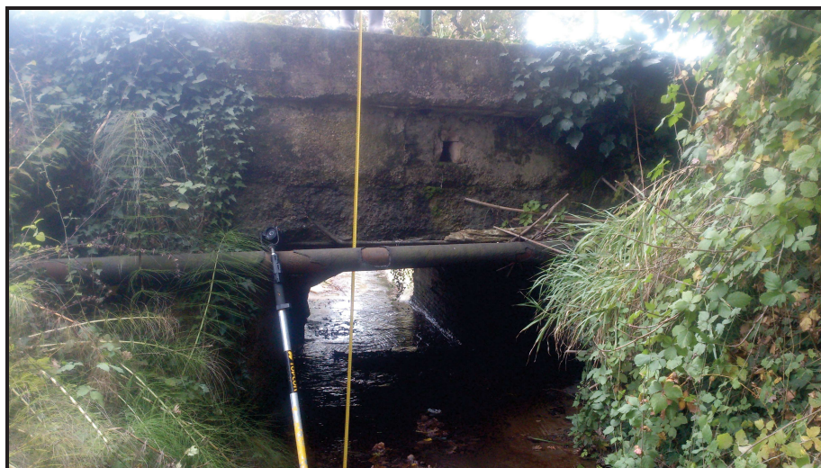
Figura 3-3 Ponte lungo via Cerreto lato di monte.
