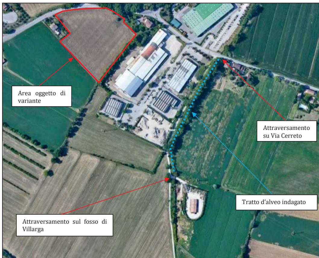
Figura 3-5 Vista aerea con indicazione delle opere descritte.
